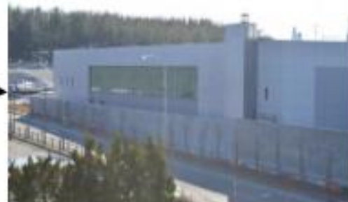
免震重要棟の写真
