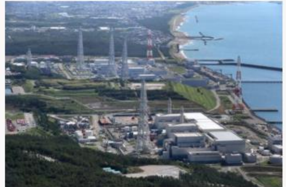
柏崎刈羽原子力発電所
